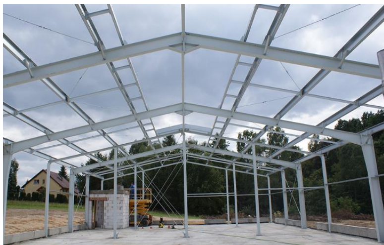
Konstrukcja ramowa hali
